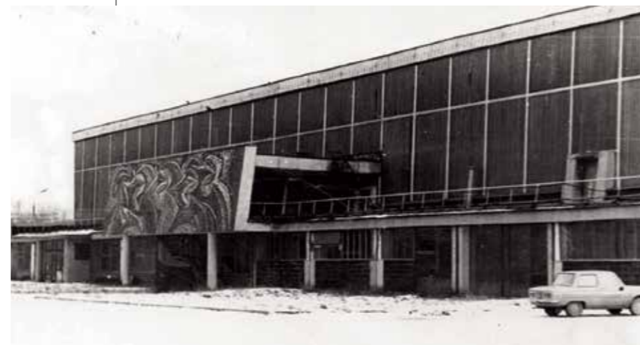
Фасад ШВЕ при ЦМИ
